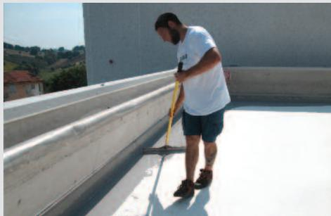
**2.** POSA DELL'AUTOLIVELLANTE IMPERMEABILE E CARRABILE POLYROOF
