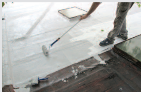
2. IMPERMEABILIZZAZIONE CON ACRYROOF PLUS + ARMATURA ACRYFELT T1
