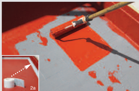
2. APPLICAZIONE DELLA PRIMA MANO DI ACRYROOF PLUS FIBRO + BANDA CASABAND SA (2a)
