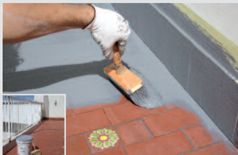
1. APPLICAZIONE DI PRIMER MULTIFIXO 100 SU BALCONE PAVIMENTATO
