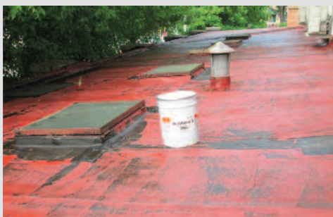
1. PRIMERIZZAZIONE CON ACRYBASE S SU TUTTA LA SUPERFICIE IN GUAINA BITUMINOSA O METALLO
