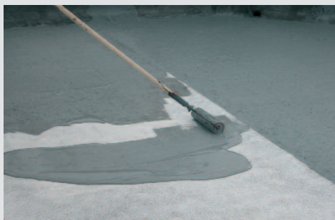
1. DERMACEM: APPLICAZIONE A RULLO / IMPREGNAZIONE DELL'ARMATURA
