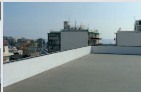
3. LAVORO FINITO E PRONTO PER ESSERE PAVIMENTATO CON PIASTRELLE O CON UNO STRATO PEDONABILE ANTI-USURA IN RESINA ACRYTOP
