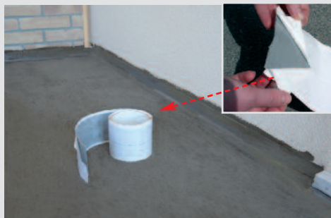
2. IMPERMEABILIZZAZIONE GIUNTI E RACCORDI CON CASABAND SA
