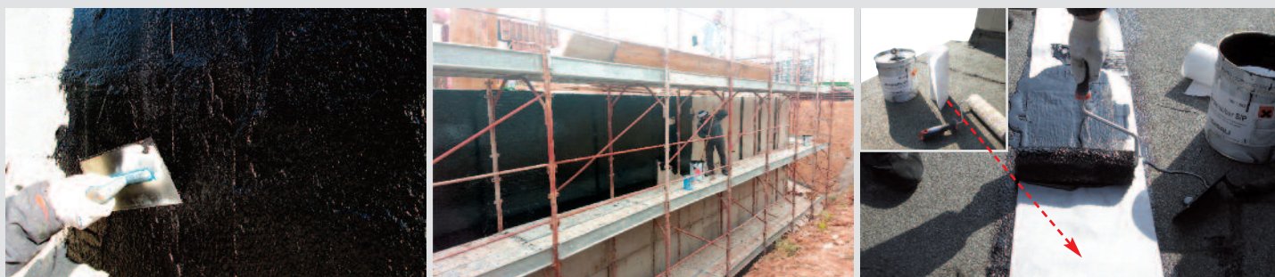
● DERMARUBBER S: APPLICAZIONE A SPATOLA SU MURO DI FONDAZIONE CON FORTI POROSITÀ
